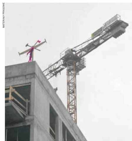
W najbliższych dniach rozpoczną się prace wykończeniowe
