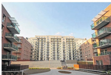
Budynki ozdobi harmonijne połączenie elementów z naturalnych materiałów, w ciepłych i chłodnych barwach
